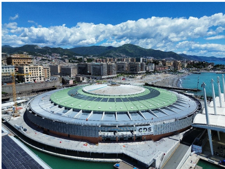
Figura 2 Il palazzetto dello sport
