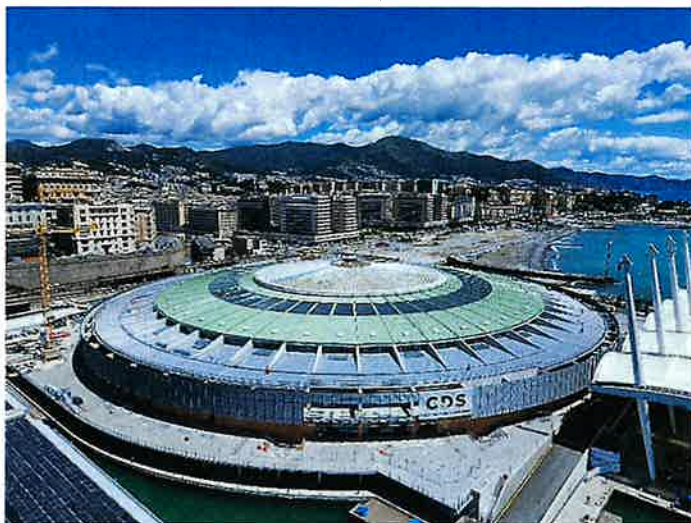
Figura 2 Il palazzetto dello sport
